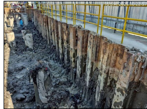
ภาพที่ 56 Sheet Pile
