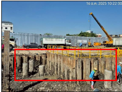
ภาพที่ 56 Sheet Pile
